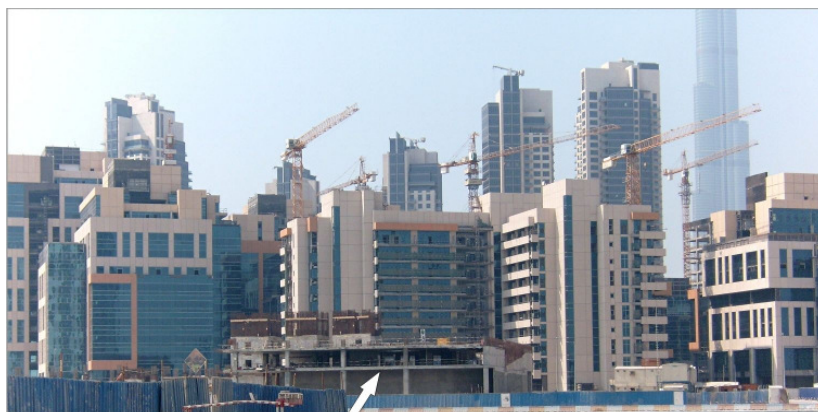
Im Vordergrund: Baustelle Boris Becker Tower. Im Hintergrund viele bereits fertig gestellte Gebäude. Hinten rechts: Burj Khalifa, das höchste Gebäude der Welt.
